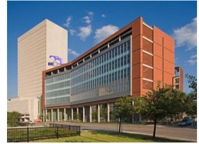
L'Edificio con sede centrale della BIO-Dynamo Reserch in California.
